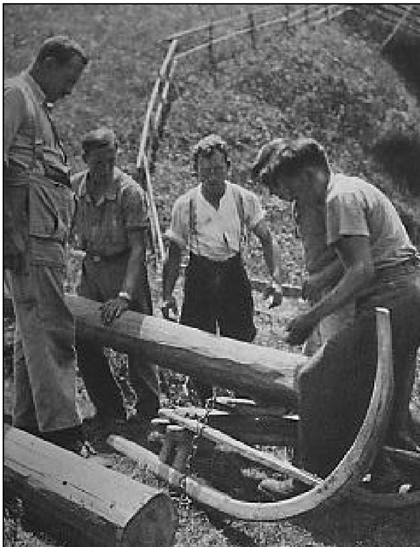
Eine Ladung Strommasten, im steilen Gelände per Hornschlitten zum Aufstellort «bewegt»...
