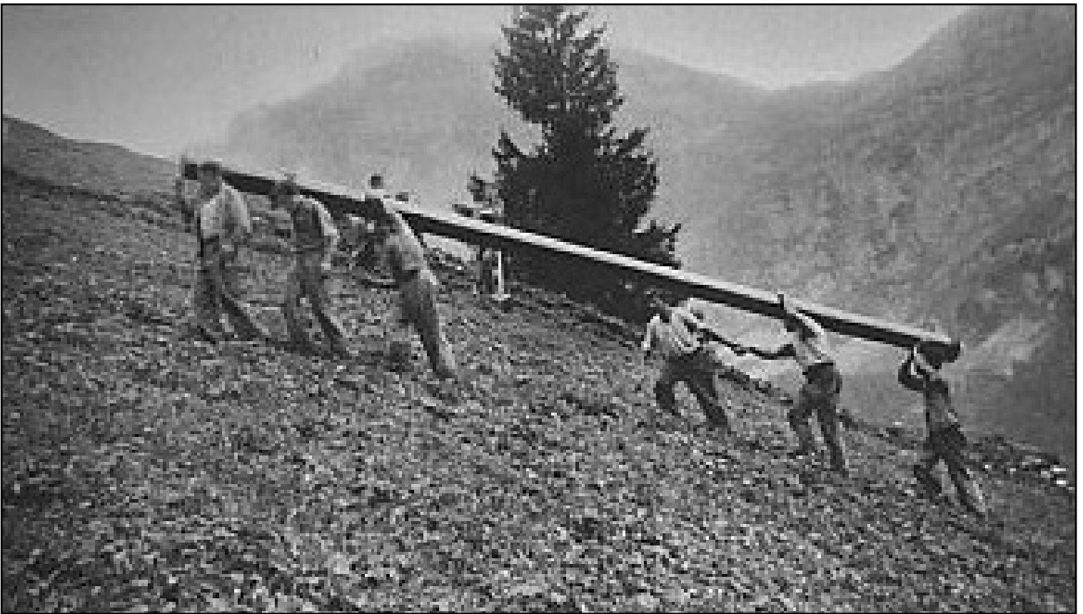
Graben, sprengen und acht Meter lange Röhren bergauf tragen.
