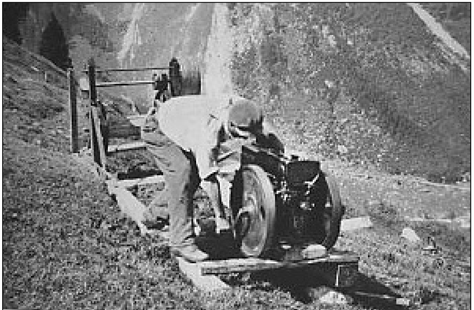
Röhrentransport am Tragseil, gezogen von einem kleinen Benzinmotor
